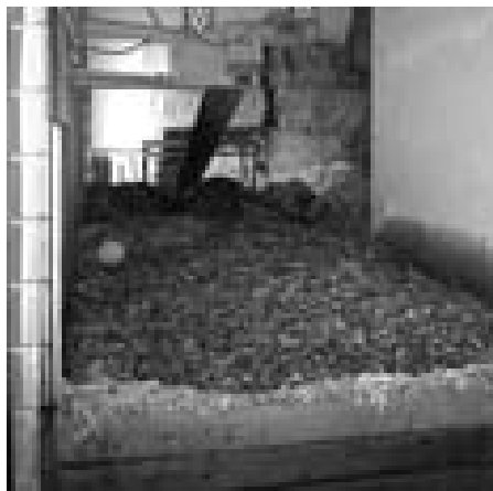
9 Kotelna ve společnosti Dibaq, a. s., o výkonu 1 500 kW používá jako palivo dřevní štěpku, piliny, pelety, Rumex OK2 ad.
