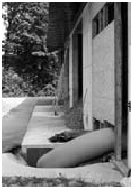
6 Sušení dřevní štěpky odpadním teplem (teplým vzduchem) z kogenerační jednotky na bioplyn. Silná ohebná trubka přivádí teplý vzduch od ventilátoru na chladiči kogenerační jednotky pod děrovaný rošt na podlaze zásobníků na štěpku.
