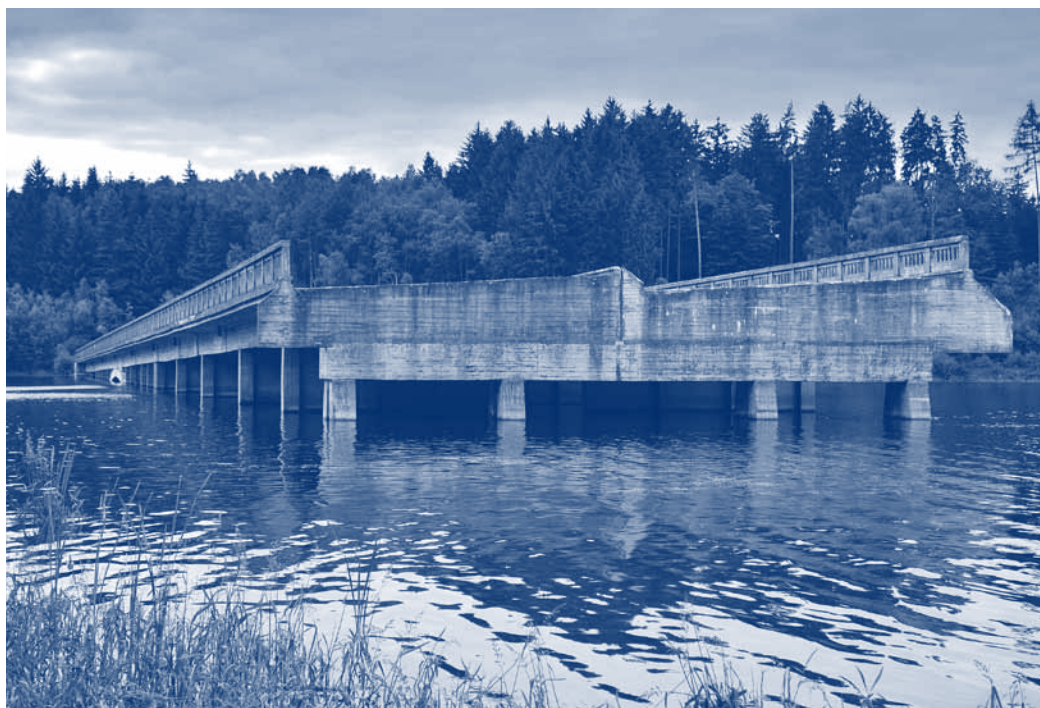
Nevyužitelný most původní československé dálnice trčí nad vodní hladinou nádrže Švihov. Definitivní trasa dálnice D1 je v těchto místech vedena v oblouku a nádrž překonává po novém mostě.
